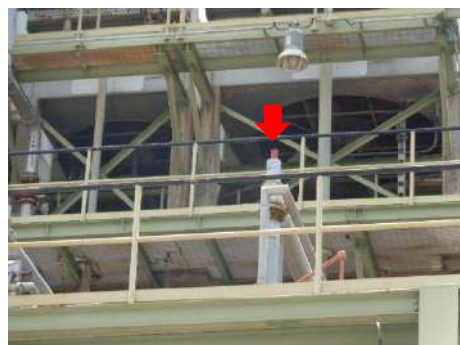
ภาพที่ 2.2-38 Pressure Relief Valve
