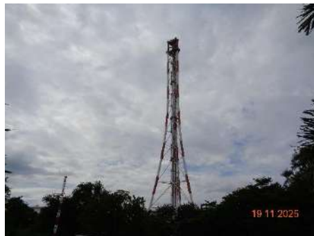
ภาพที่ 2.2-3 หอเผาที่ระดับเหนือพื้นดิน (Elevated Flare)
