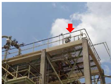
ภาพที่ 2.2-34 ระบบ Double Safety Relief Valve
